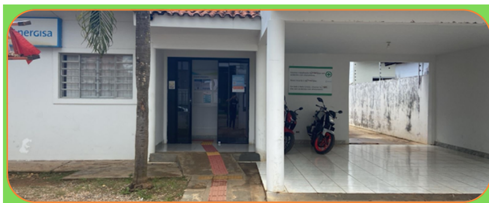
Figura 65 - Vista da fachada
