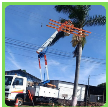
Figura 67 - Caminhão com cesto
