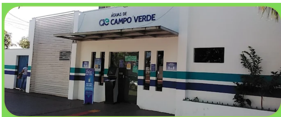
Figura 53 - Vista da fachada
