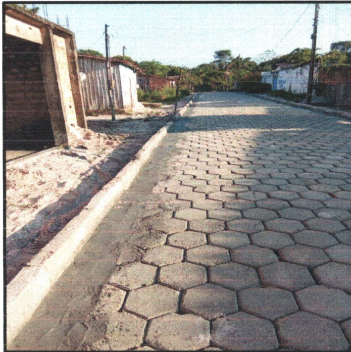
Rua Pavimentada com blocos de concreto- Rua Paulo Farias Fonte: Jhonathan Santana
