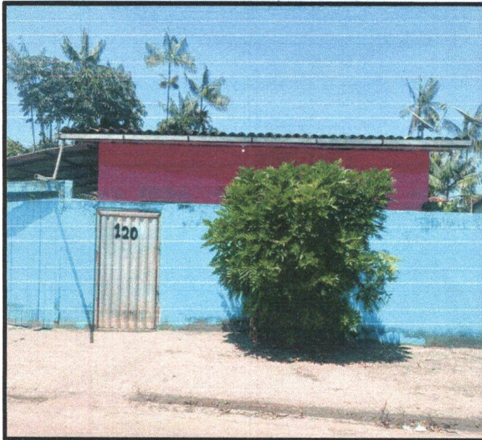
Fachada-Amostra 02 Fonte: Jhonathan Santana
