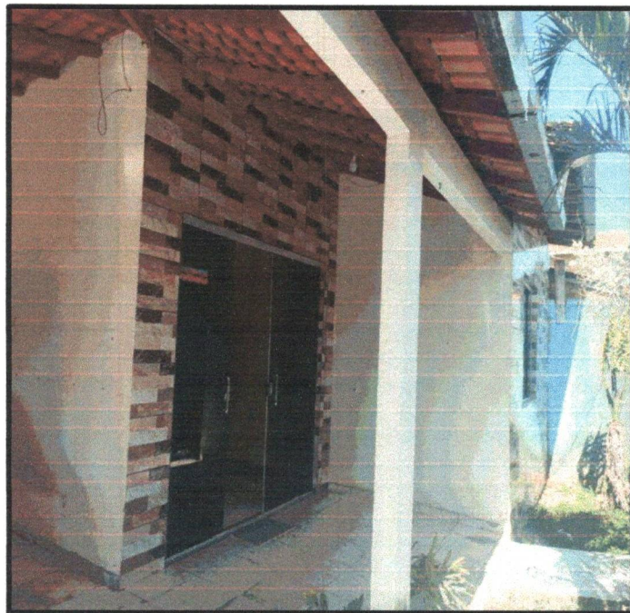
Fachada-Amostra 03 Fonte: Jhonathan Santana
