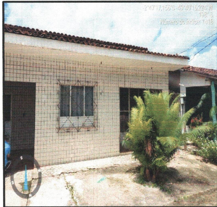
Cobertura em telha cerâmica Fonte: Jhonathan Santana
