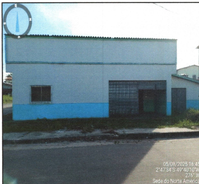
Foto 16: Vista Frontal da edificação Fonte: Igor Augusto
