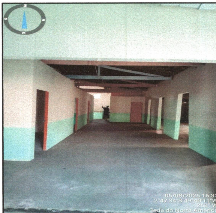
Foto 22: Hall da edificação Fonte: Igor Augusto
