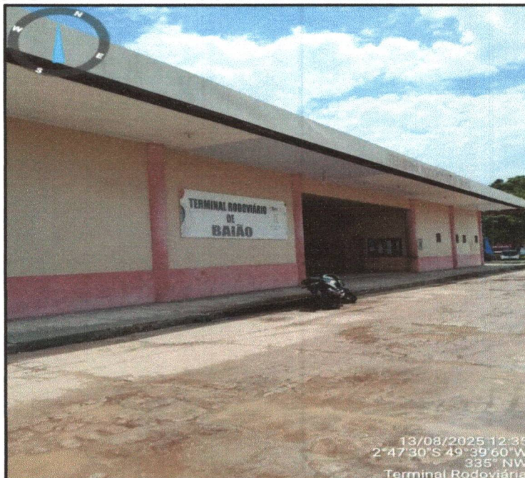
Foto 15: Terminal Rodoviário de Baião Fonte: Igor Augusto
