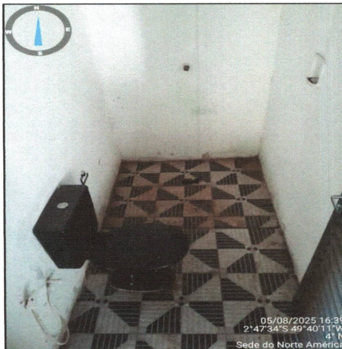
Foto 43: Banheiro Masculino Fonte: Igor Augusto
