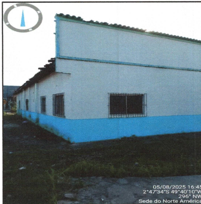
Foto 20: Vista Lateral sudeste da edificação. Fonte: Igor Augusto
