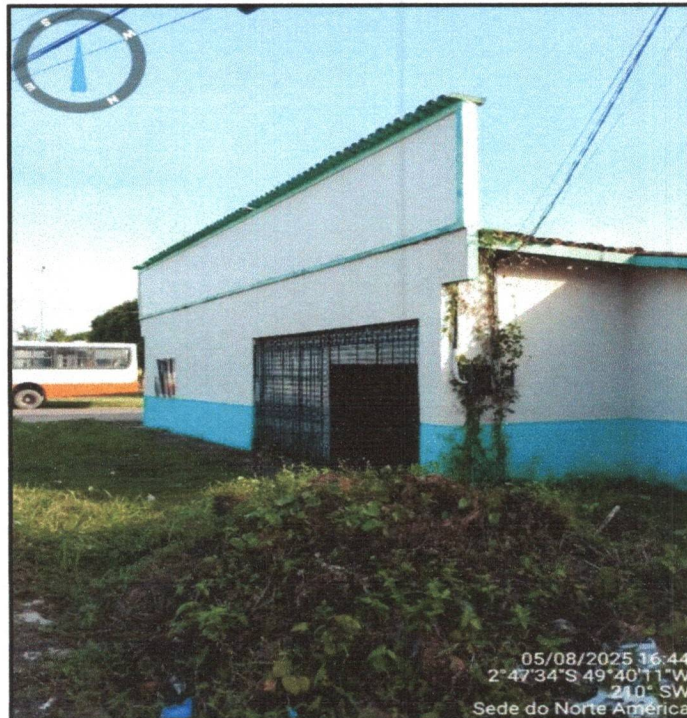
Foto 17: Vista lateral nordeste da edificação Fonte: Igor Augusto
