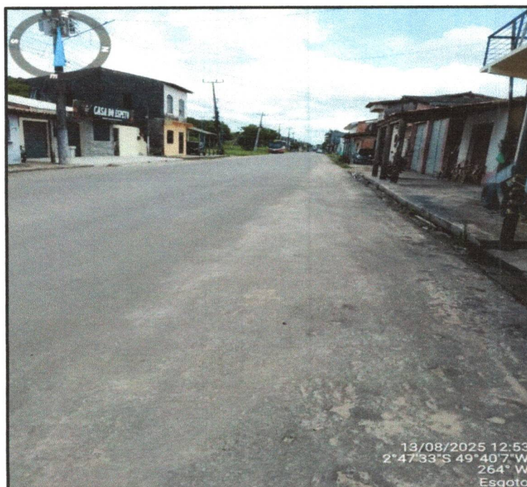
Foto 11: Pavimentação Asfáltica de ruas do bairro Fonte: Igor Augusto
