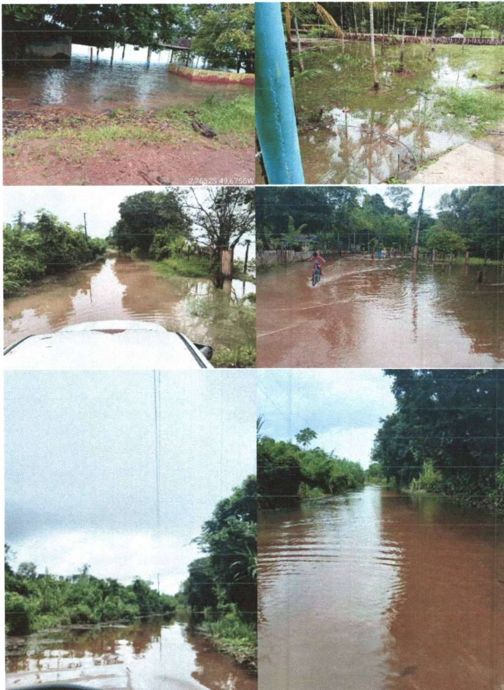
Localização: -2.755083, -49.672806. Estrada do Limão afetado pela cheia do rio Tocantins, tendo o acesso comprometido por conta do nível do rio provocada pelas chuvas dificultando a circulação de mercadorias e pessoas.
