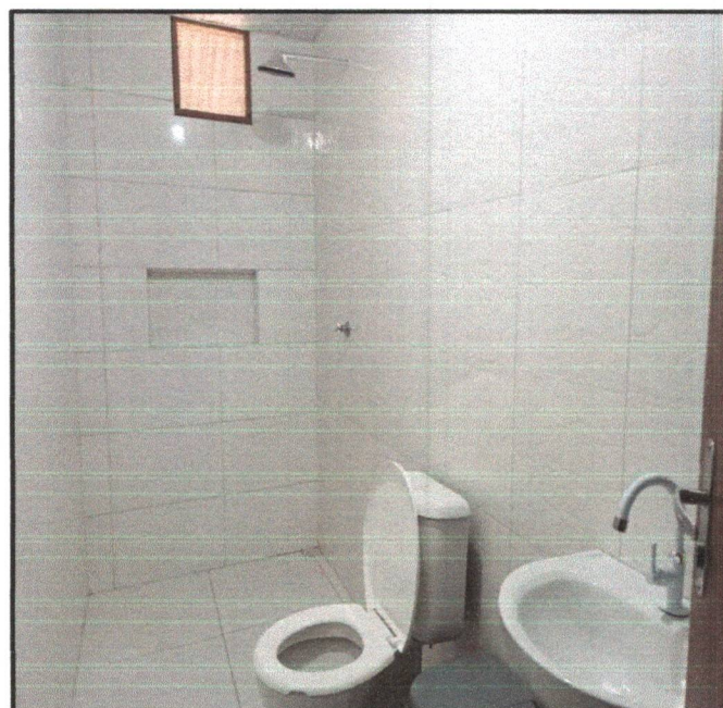
Banheiro da Unidade Fonte: Reinaldo Patric R. Sampaio
