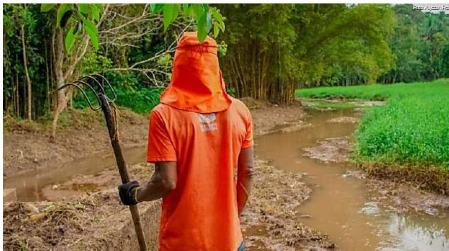
Figura 110: Serviço de limpeza de leito de igarapé executado pela equipe SEMOVI
