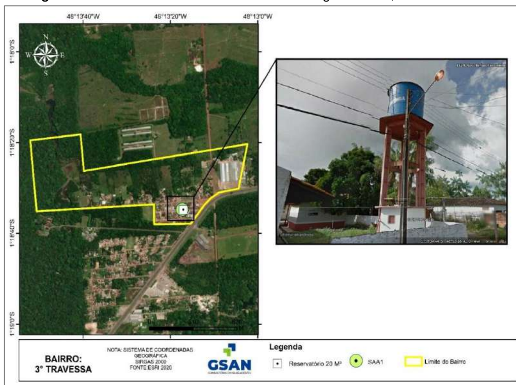
Figura 45: Microssistema de abastecimento de água SAA01, Bairro Terceira Travessa
