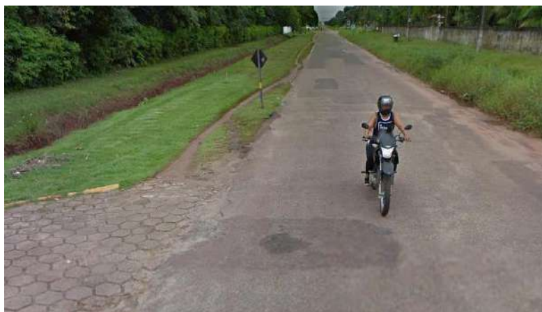
Figura 99: Inexistência de meio-fio na PA-406, em frente à Organização Palavra da Vida, Bairro Presidente Médice
