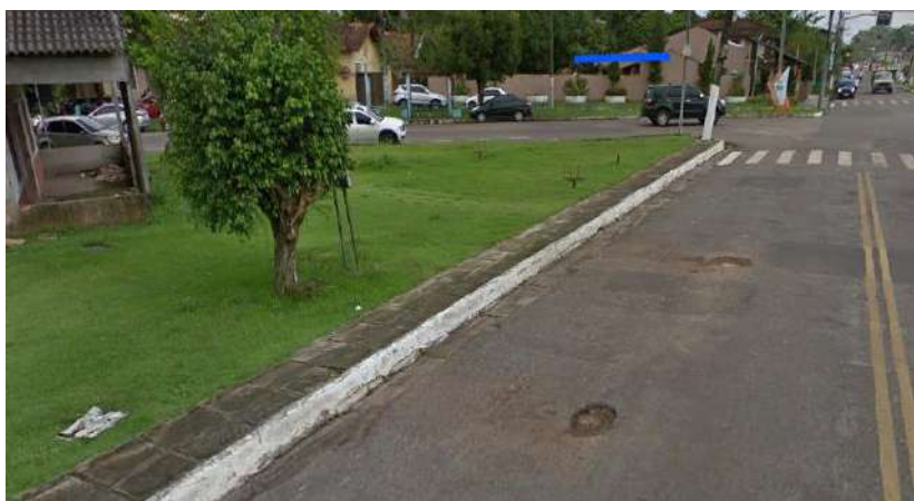
Figura 96: Meio-fio e sarjeta da Rua Nações Unidas próximo à Av. João Fanjas, Bairro Centro
