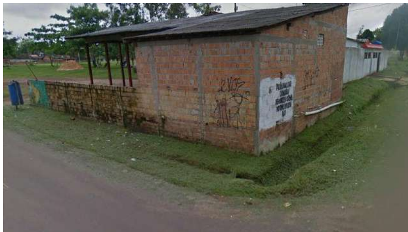
Figura 104: Canaleta em solo na Rua Leão Delgado com a Av. Perimetral Sul, Bairro Duque de Caxias
