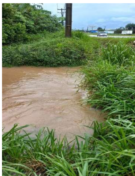
Figura 128: Alagamento ocorrido BR-316, município de Benevides- 2022
