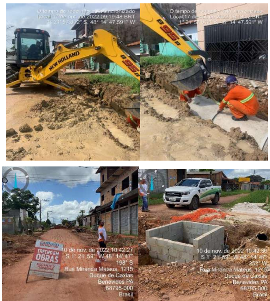
Figura 93: Obra de drenagem da Rua Miranda Mateus, Bairro Duque de Caxias
