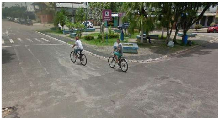
Figura 97: Meio-fio e sarjeta presentes na Rua Pinto Braga com Rua Paul Begot, Bairro Centro
