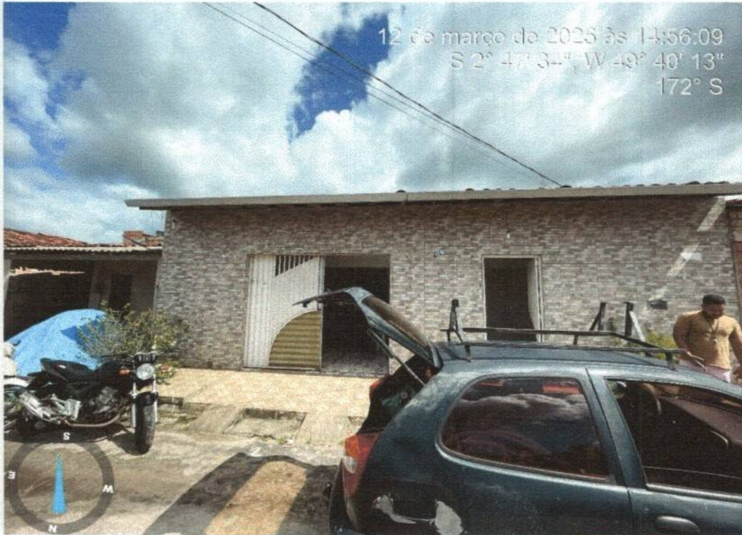
Imagem 02- Entrada do prédio
