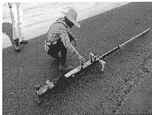
VIGA BENKELMAN EM OPERAÇÃO.
