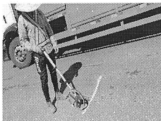
ESTAQUEAMENTO DA VIA
