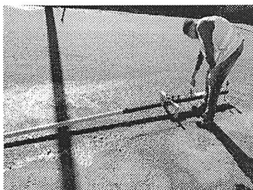
VIGA BENKELMAN EM OPERAÇÃO.
