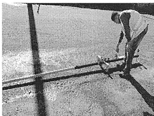
VIGA BENKELMAN EM OPERAÇÃO.
