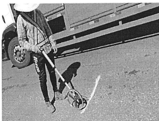
ESTAQUEAMENTO DA VIA
