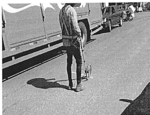
ESTAQUEAMENTO DA VIA
