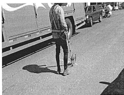
ESTAQUEAMENTO DA VIA
