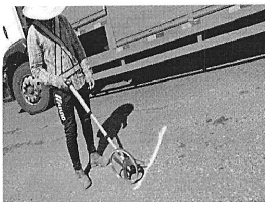
ESTAQUEAMENTO DA VIA
