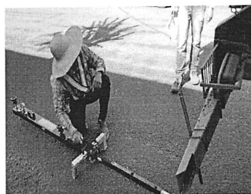
VIGA BENKELMAN EM OPERAÇÃO.
